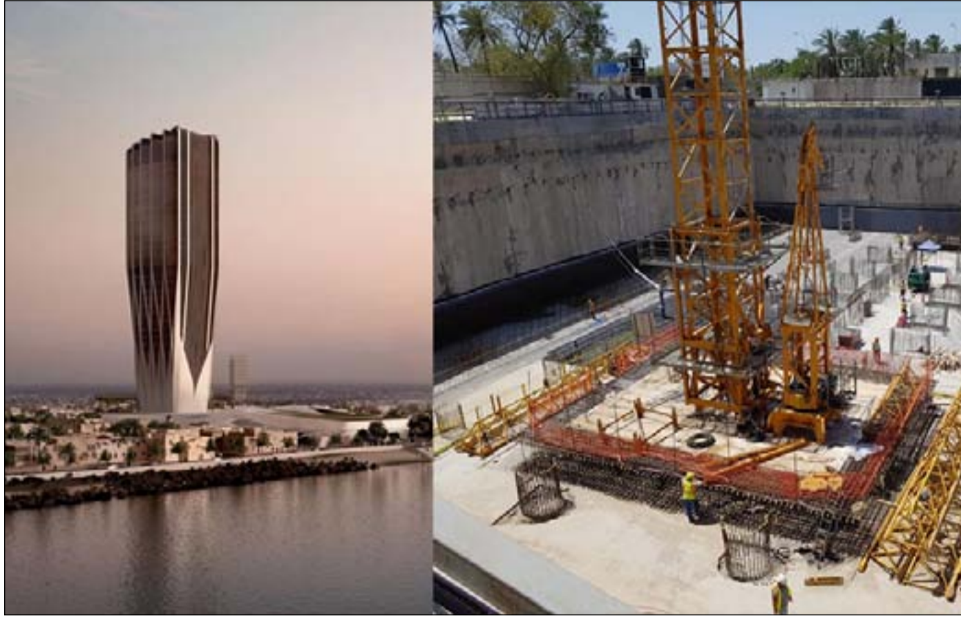
صورتان لمبنى البنك المركزي الاولى اثناء الانشاء، والثانية صورة متوقعة لشكل المبنى بعد انجازه
